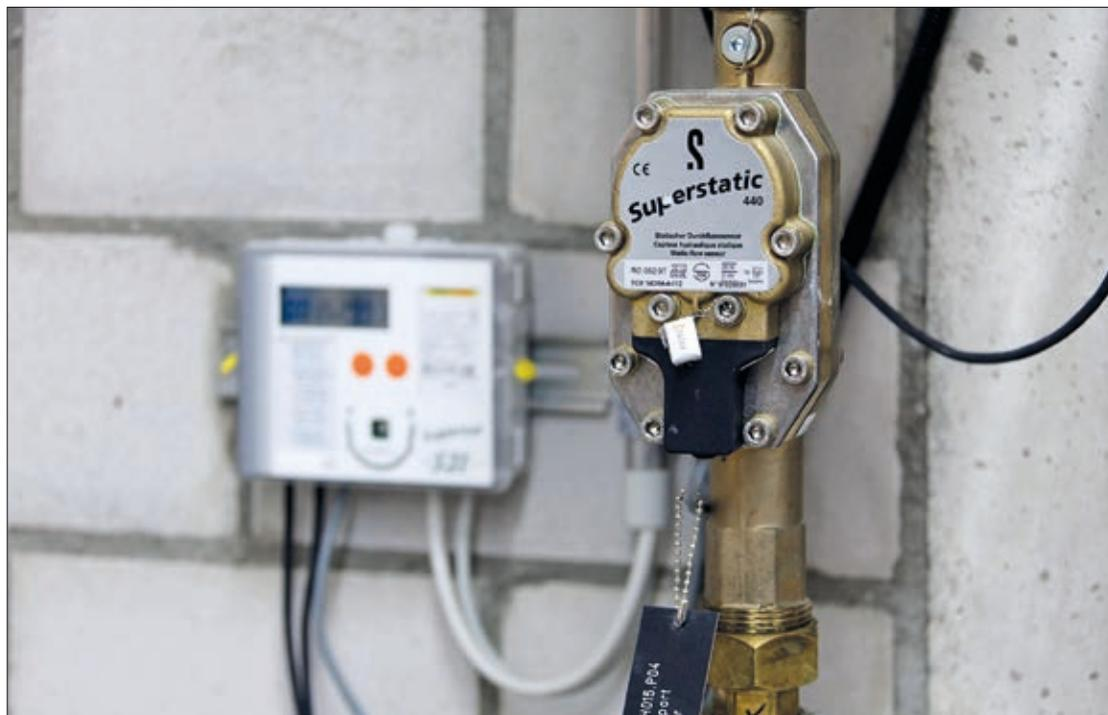
Système de comptage d'énergie avec télé-relève.
