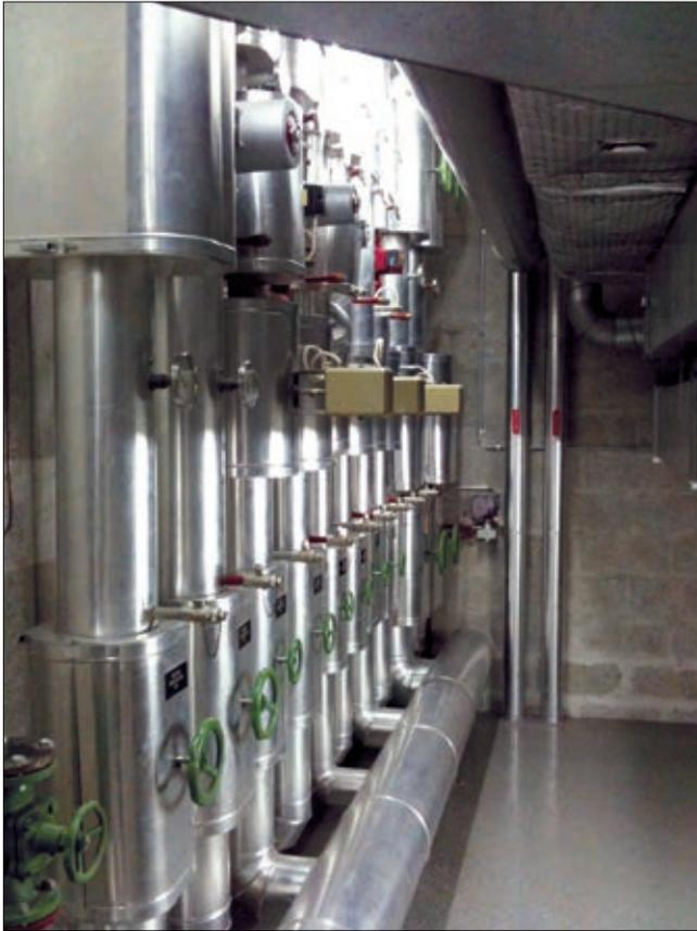
A Vevey, La Poste a reçu un certificat «or» pour ses excellents résultats obtenus au terme de la démarche energo: optimisation des courbes de chauffe, adaptation des horaires de chauffage, création de zones neutres entre la production de chaleur et de froid, ajustement des horaires et des débits de fonctionnement de la ventilation, optimisation de la température du réseau d'eau glacée. Le bâtiment a obtenu une réduction de 35% du besoin en chaleur et de 9% du besoin en électricité.
