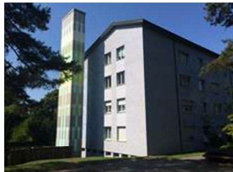
MPK Wohnliegenschaft in Urdorf: Dank der energo@ADVANCED Betriebsoptimierung vermindern sich die jährlichen Kosten für Heizung und Allgemeinstrom um Fr. 22'500.- und der CO 2 -Ausstoss wird um 65 to/J. reduziert.
