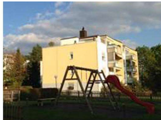
MPK Wohnliegenschaft in Oetwil a. d. L.: Dank der energo@ADVANCED Betriebsoptimierung vermindern sich die jährlichen Kosten für Heizung und Allgemeinstrom um über Fr. 23'000.- und der CO 2 -Ausstoss wird um 72 to/J. reduziert.
