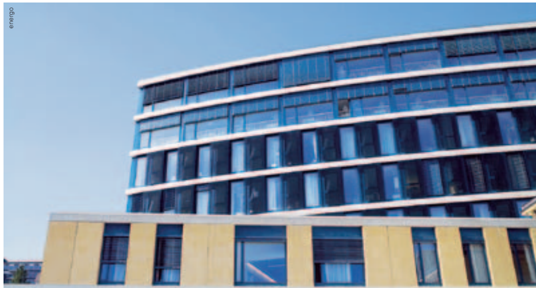
Energétiquement optimisé: l'Hôpital Pourtalès à Neuchâtel.
