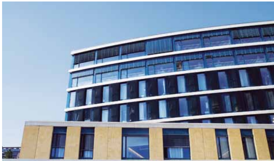
Ospedale Pourtalès di Neuchâtel: le esperienze di ottimizzazione di energo si estendono anche alle nuove costruzioni, che spesso presentano interessanti potenziali di risparmio.
