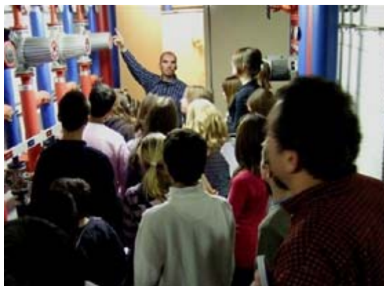
Visite de la chaufferie du collège avec M. Chapalay, concierge et M. Bonjour, ingénieur
